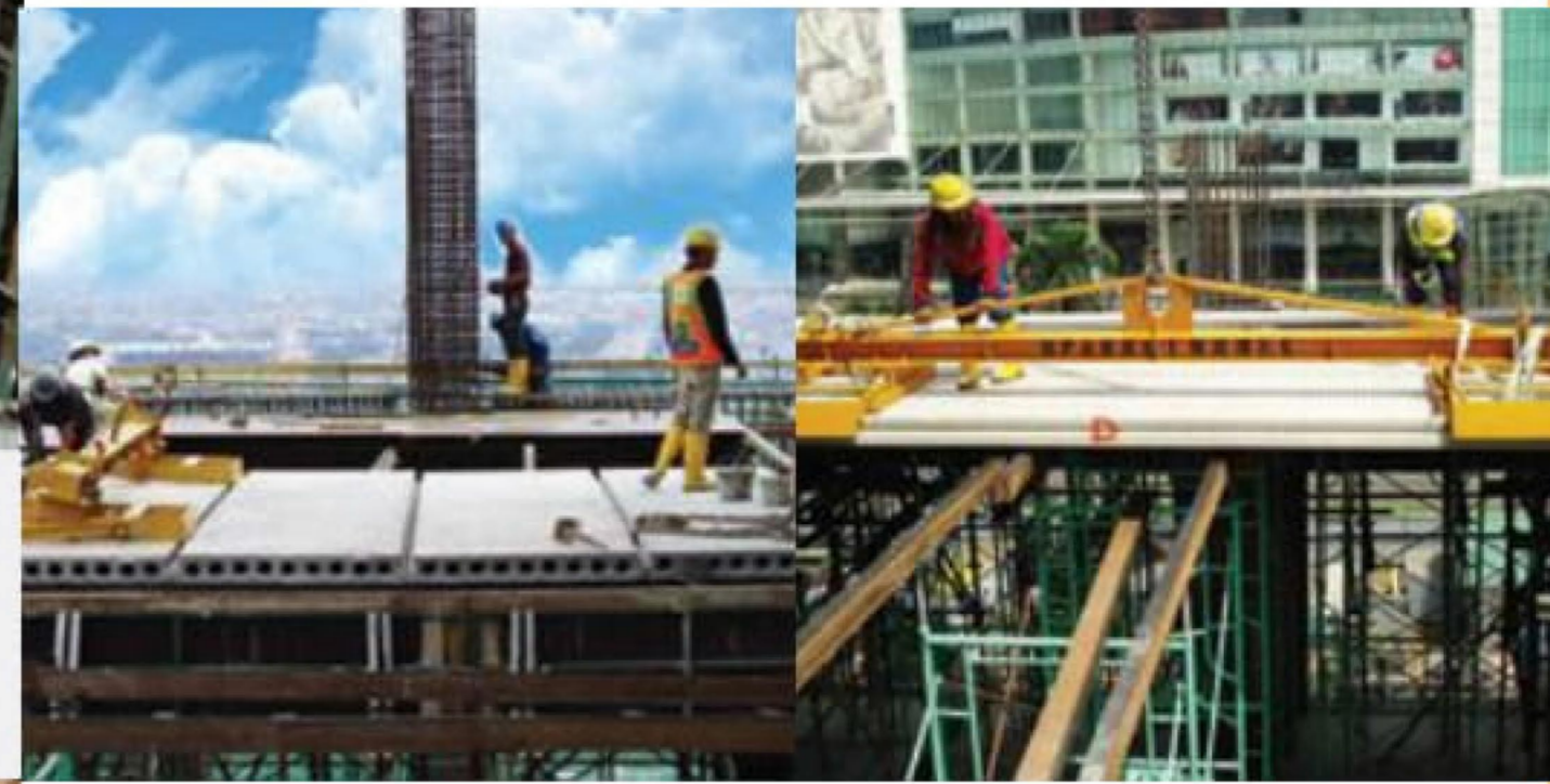
PEMASANGAN HCS SECARA SIMULTAN
